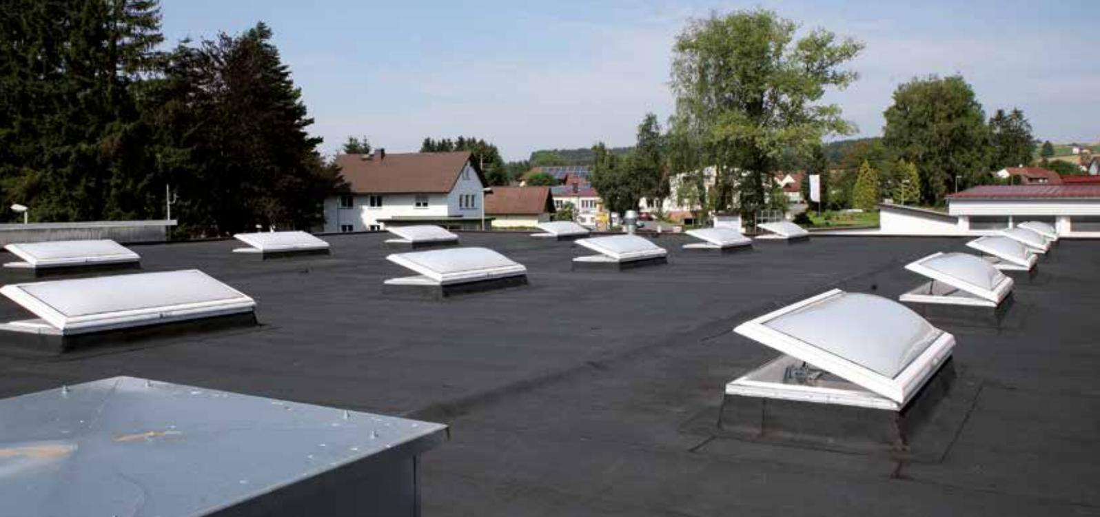
Подробные теплотехнические расчёты подтверждают высокий уровень теплоизоляции зенитных фонарей F100. Идеальное в энергетическом плане сочетание таких компонентов, как остекление, рама и система изоляции, обеспечивает отличный коэффициент теплопроводности ( $U_w$ ).
