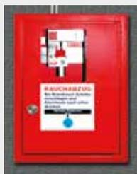
Аварийный ящик для включения установки вручную
