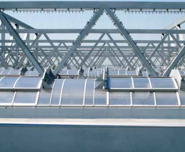
Объект: Ангар технического обслуживания аэробусов А380, Франкфурт-на-Майне
