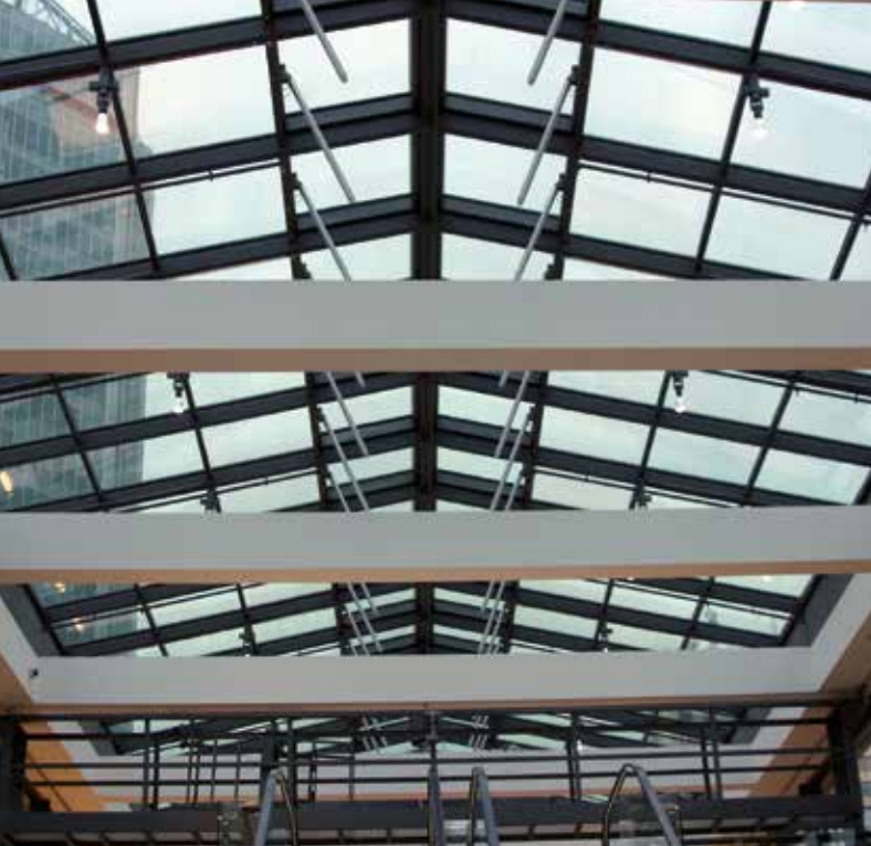
Объект: Торговый центр „Аркады Панкрац“ в Праге
