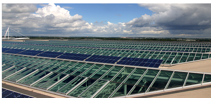
Ленточные зенитные фонари с люками дымоудаления на терминале 2 аэропорта мюнхен
