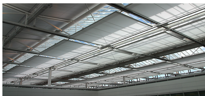
Ленточные зенитные фонари с люками дымоудаления на терминале 2 аэропорта мюнхен
