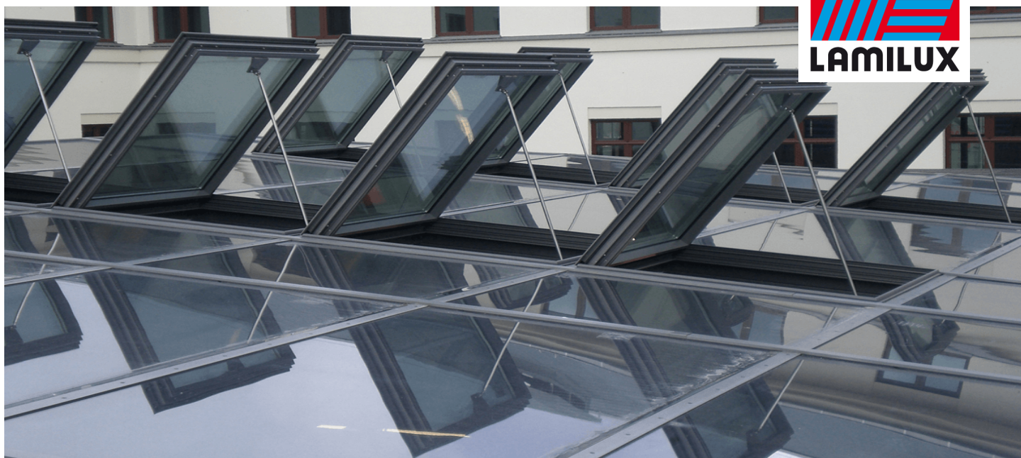
Стойчно-ригельная конструкция с люками дымоудаления в торговом центре, брауншвейг, германия
