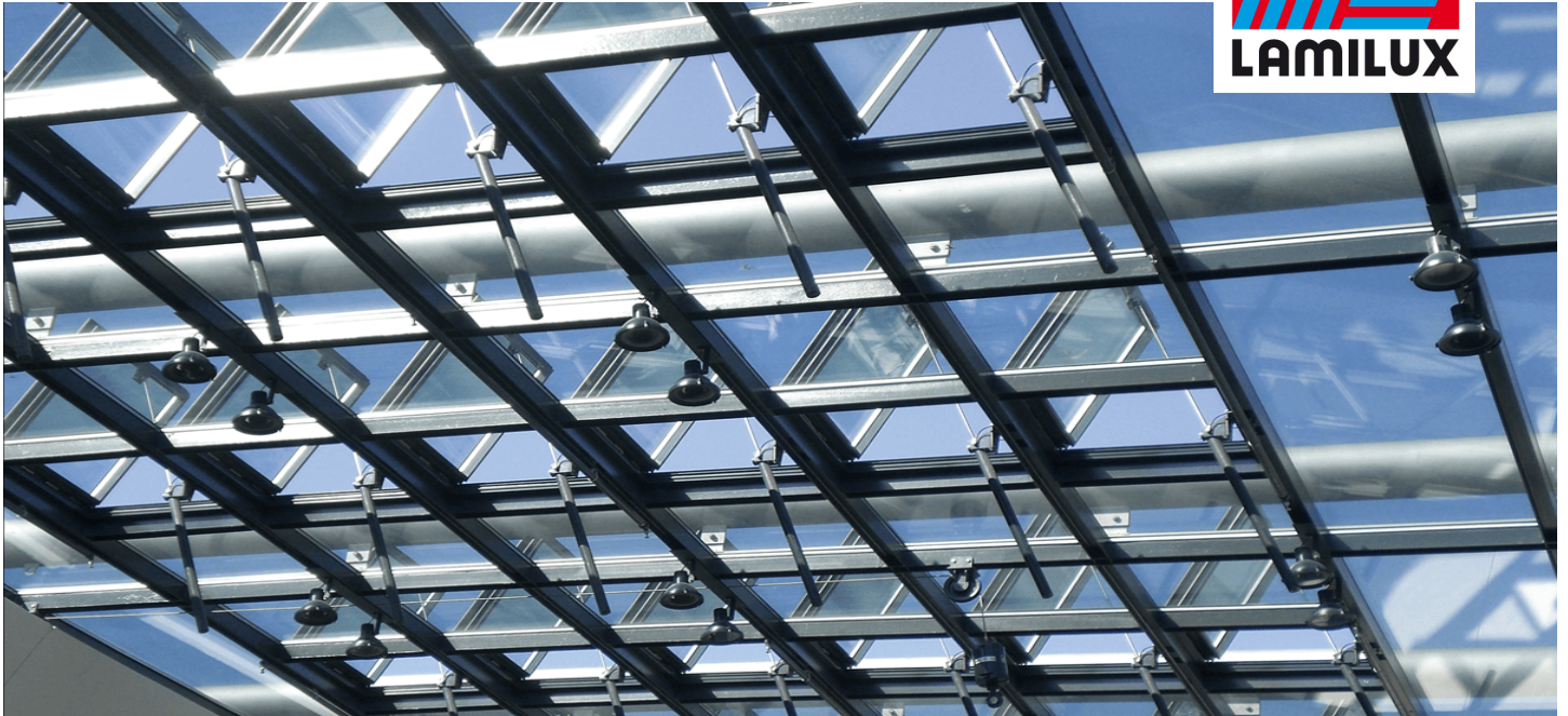
Стойечно-ригельная конструкция с люками дымоудаления в торговом центре, брауншвейг, германия
