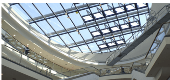
Стойчно-ригельная конструкция с люками дымоудаления в торговом центре, брауншвейг, германия
