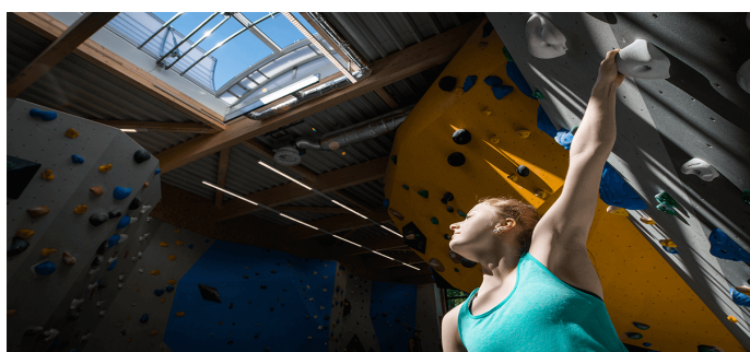
Ленточные и точечные зенитные фонари на альпинистском центре в бракеле, германия
