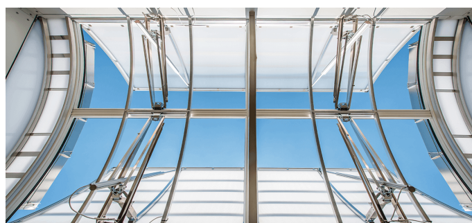
Ленточные и точечные зенитные фонари на альпинистском центре в бракеле, германия
