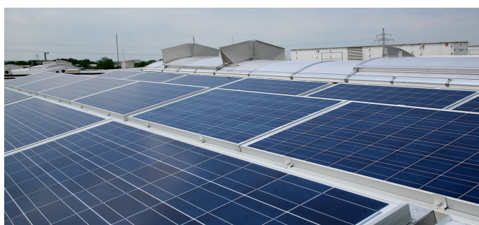
Зенитные фонари ленточного типа на производственном здании schneider electric, регенбург, германия
