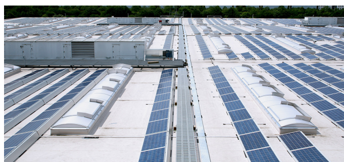
Зенитные фонари ленточного типа на производственном здании schneider electric, регенбург, германия
