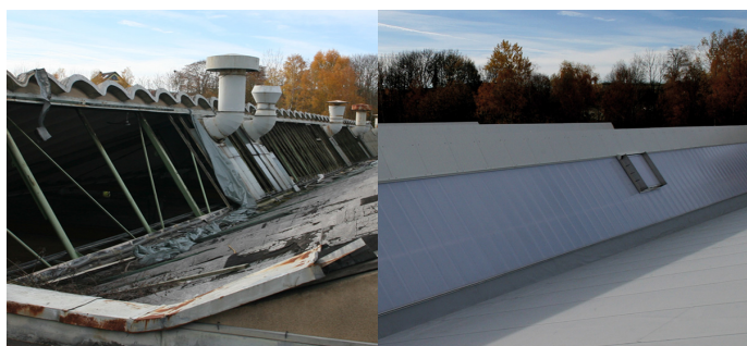
Реконструкция кровельных фонарей производственного цеха в бад шлеме, германия
