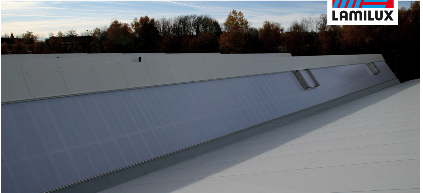
Реконструкция кровельных фонарей производственного цеха в бад шлеме, германия
