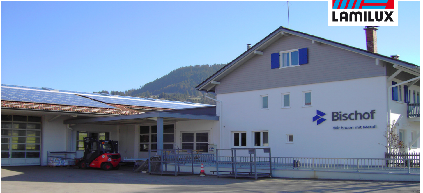
Реконструкция кровельных фонарей производственного цеха в зонтофен, германия
