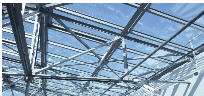
Стеклянные конструкции с люками дымоудаления в университете музыки и искусств, мюнхен
