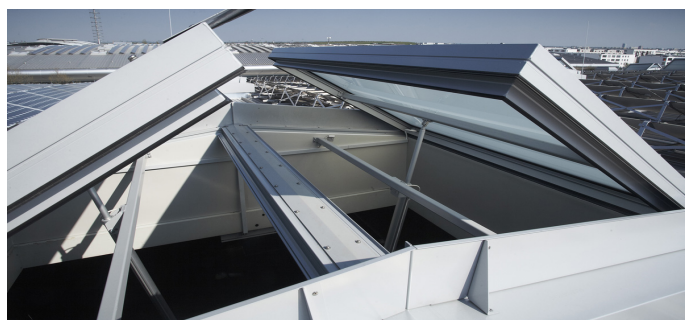
Двустворчатые люки дымоудаления на выставочном зале в мюнхене, германия
